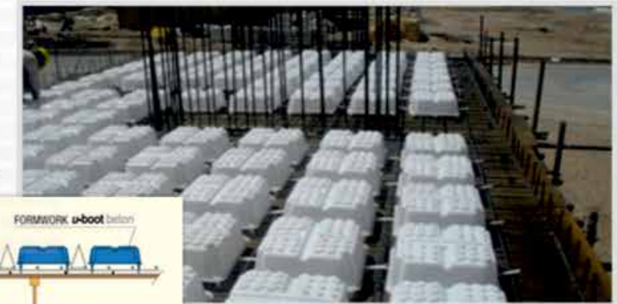
۲- قراردادن یوبوت ها در سقف
