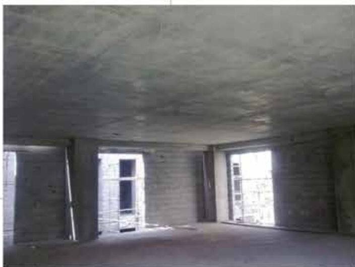
کاهش هزینه های مربوط به قالب بندی به جهت حذف آویز تیر های در دهانه بلند
