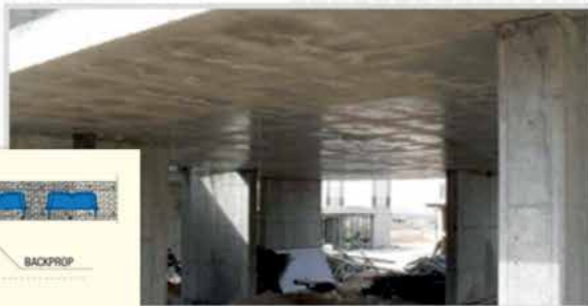
۶- باز کردن قالب ها
